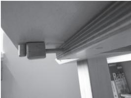
Auf einer Seite des Oberteils ist ein Dübel befestigt, dieser dient zur Fixierung des Oberteils an der Befestigungsplatte des Stiels.
